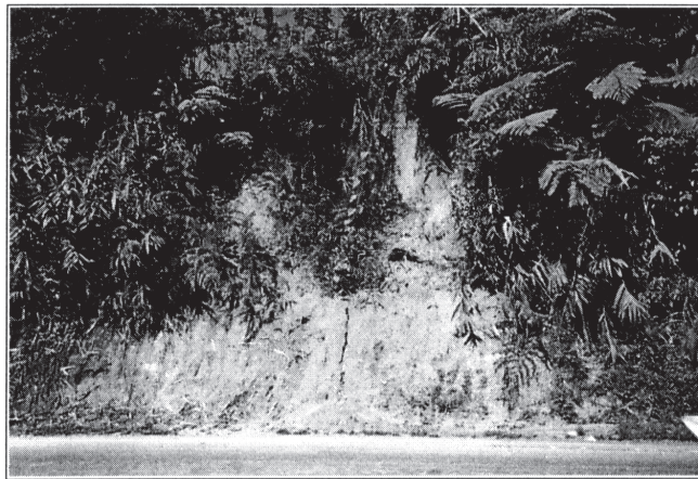
RAJAH 2. Kegagalan jenis gelinciran cetek. Keadaan cerun yg terdedah dan curam serta bahan cerun yang lemah menyumbang ketidakstabilan cerun. Lokality: Stesen LSF
